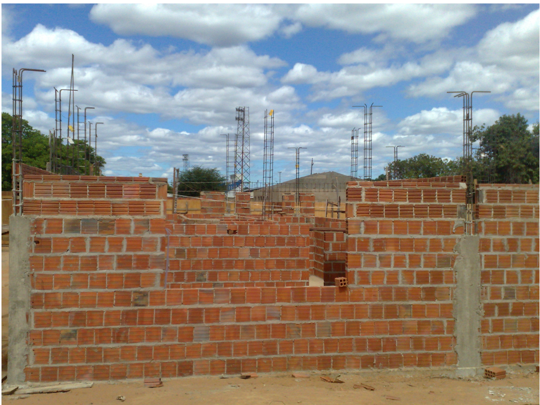
Foto 03 - Vista geral de alvenarias
