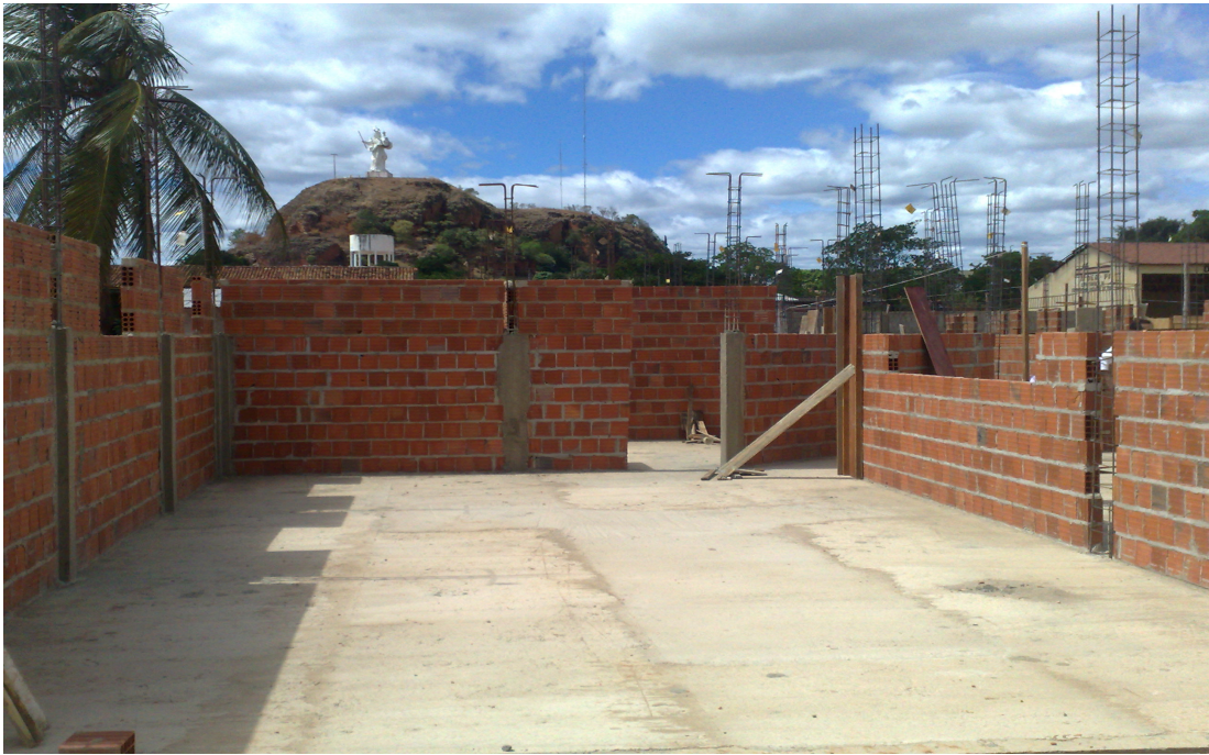
Foto 02 - Vista da Secretaria da Vara
